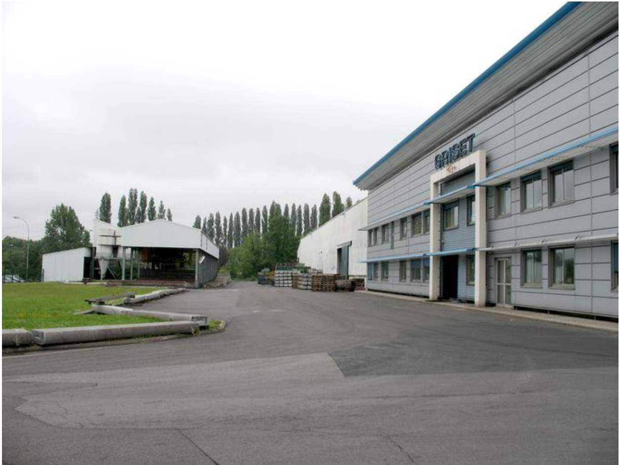
Le bâtiment administratif (au premier plan) et les hangars de stockage des métaux.
