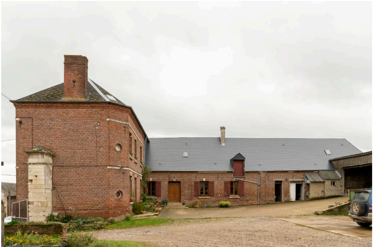
Vue générale du logis depuis le nord.
