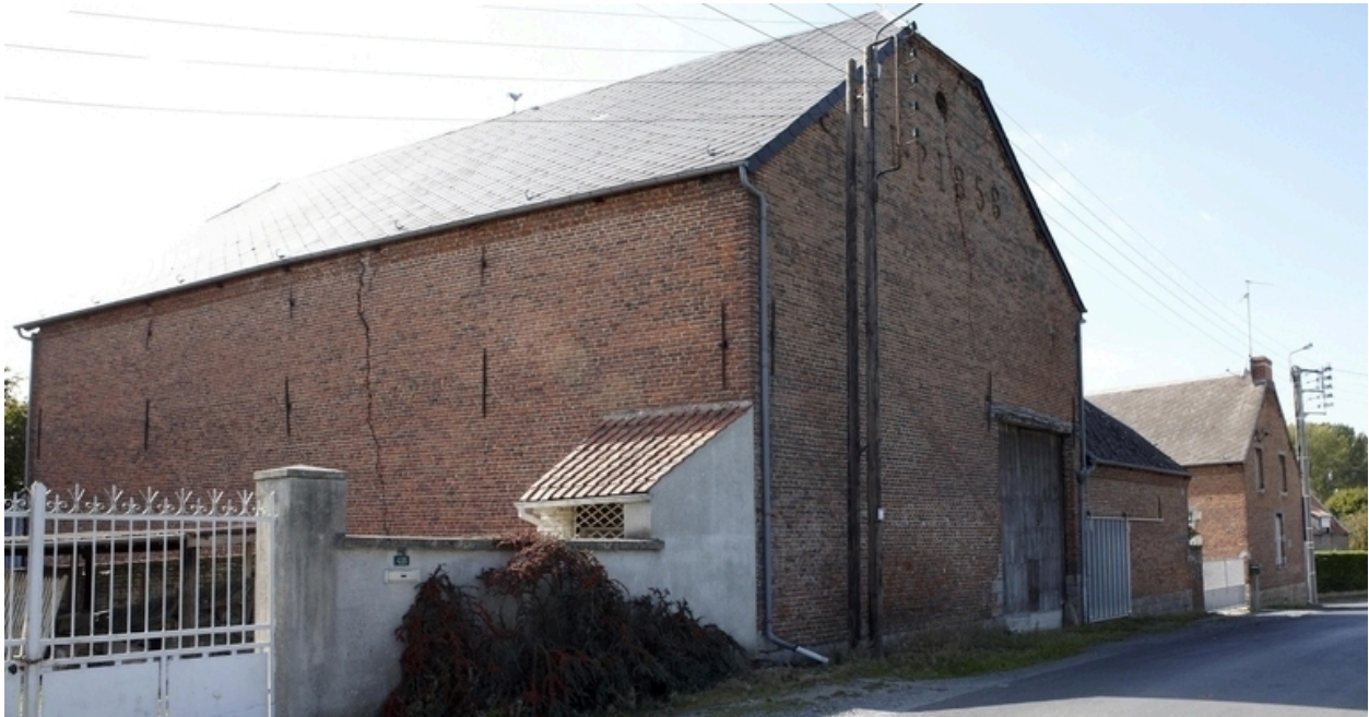
Vue de la seconde grange, depuis la rue Albert-Fenez.
