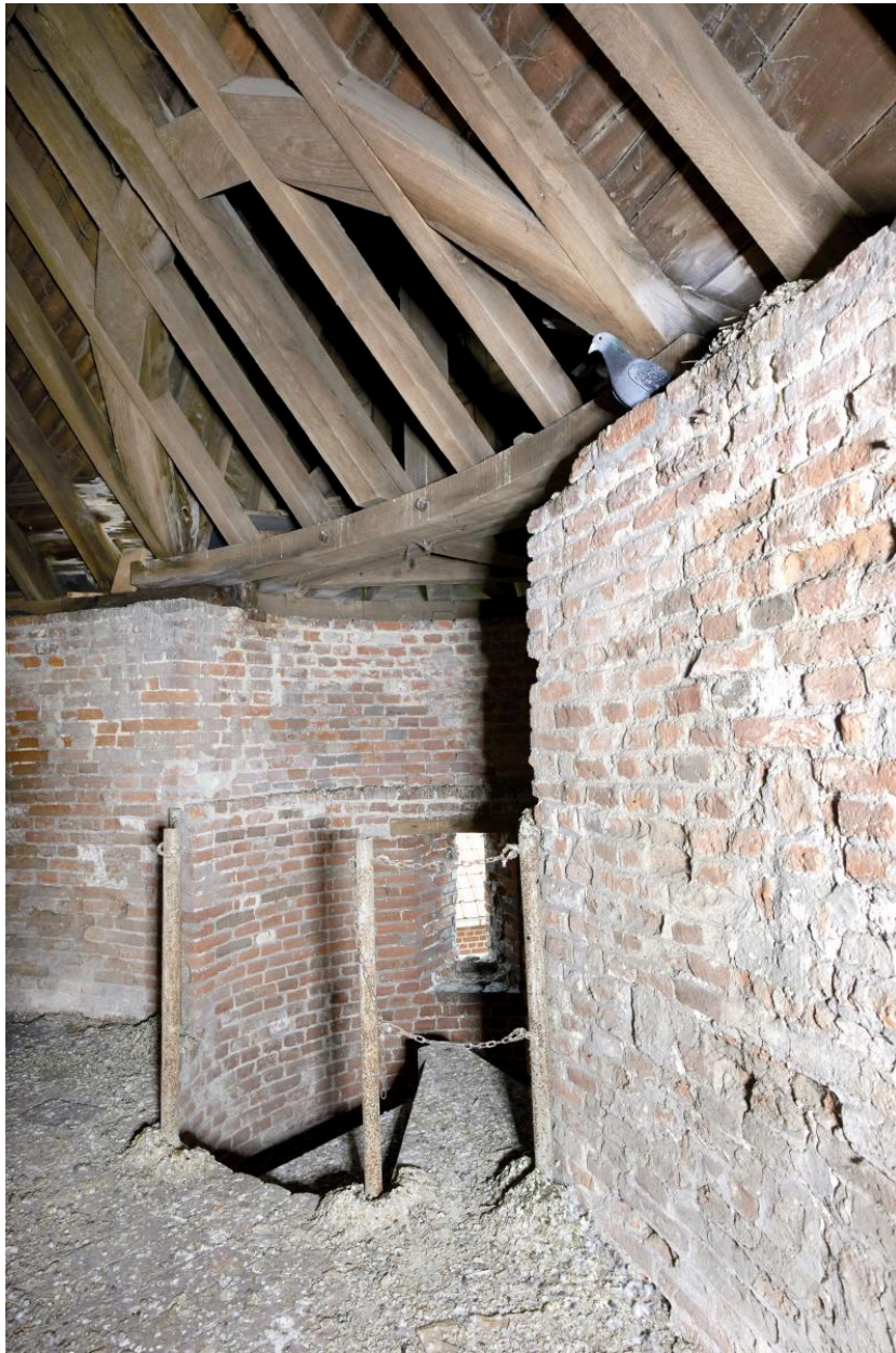
Chemin de ronde. Vue vers la tour d'escalier et la charpente du début 20e s.
