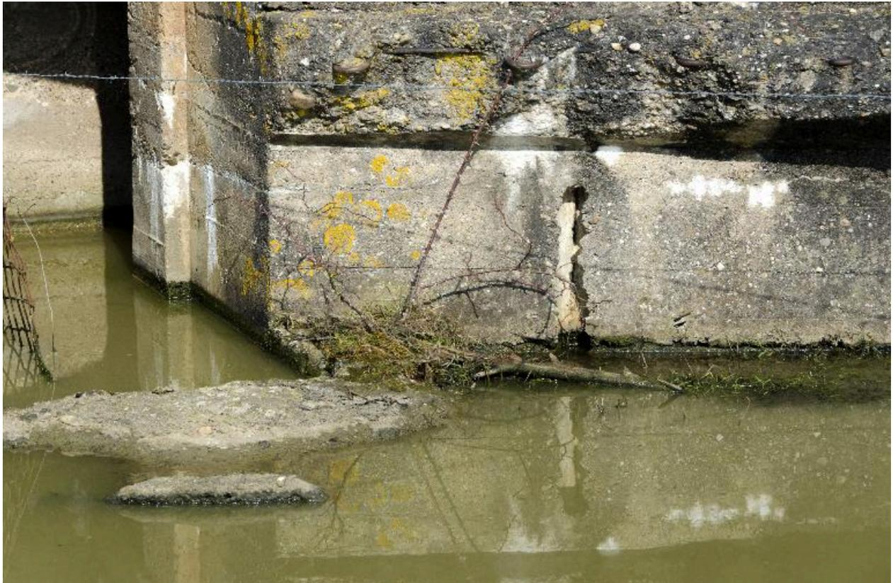
Élévation sur, entrée ouest, empreinte d'un piquet de maintien du coffrage, lors de la construction
