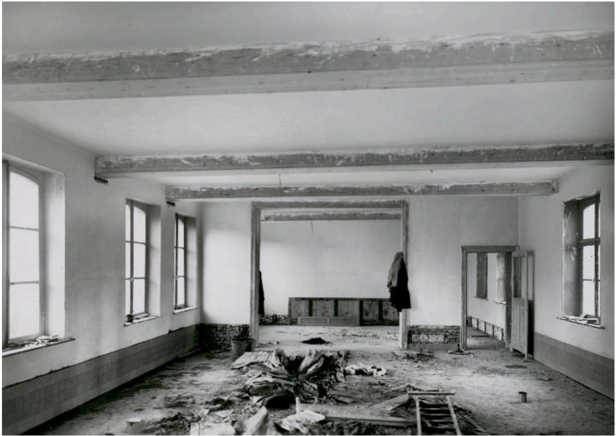
Vue générale de la crèche de l'usine d'Abbeville en cours d'aménagement intérieur, Jean-Pierre Jacquart (photographe), 1937.
