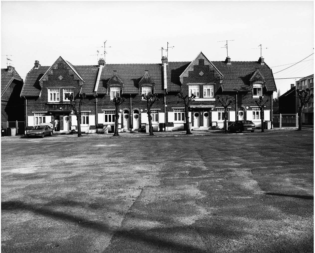
Vue générale du premier groupe de maisons, aile sud.
