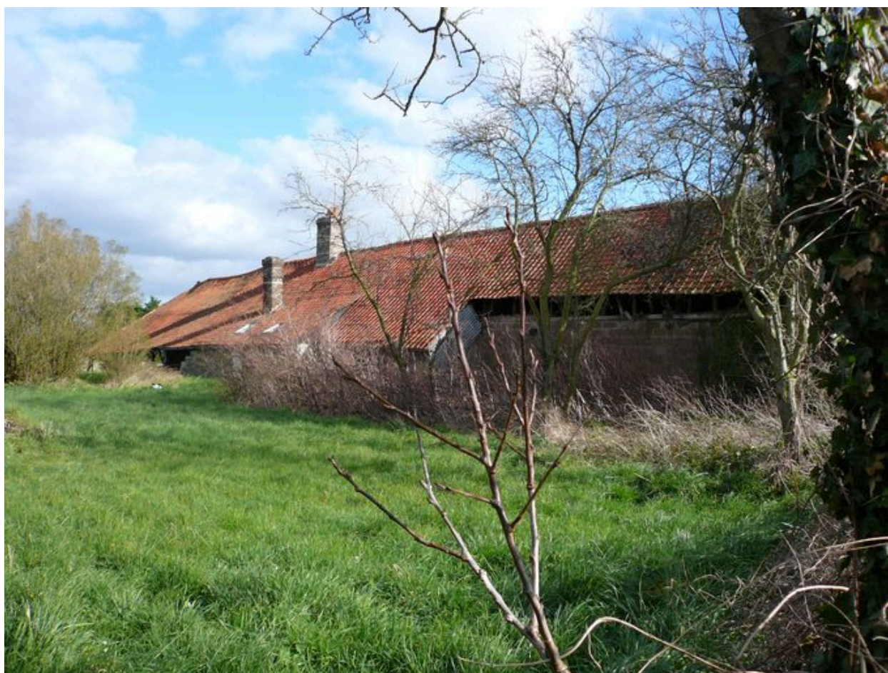
Vue postérieure du logis.
