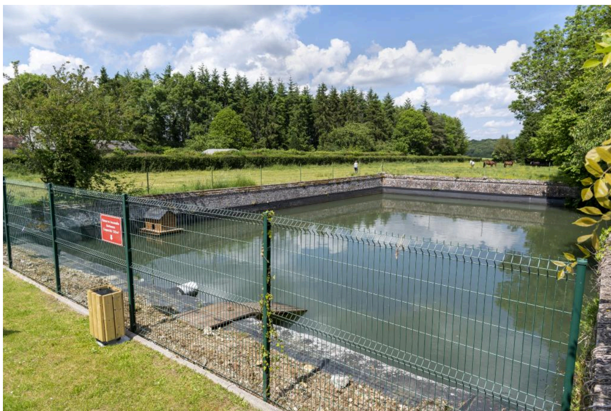
Mare, à côté du n°13 Grande Rue.
