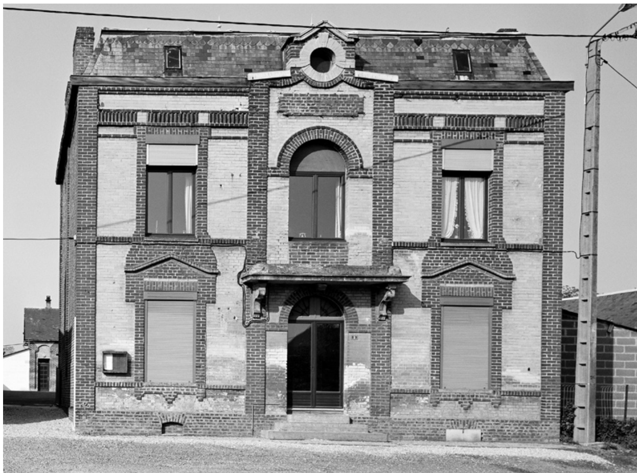
Façade de l'ancienne mairie-école construite vers 1910.
