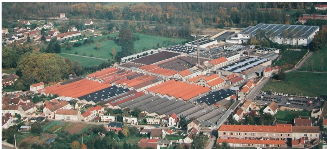
Vue aérienne de l'usine.
