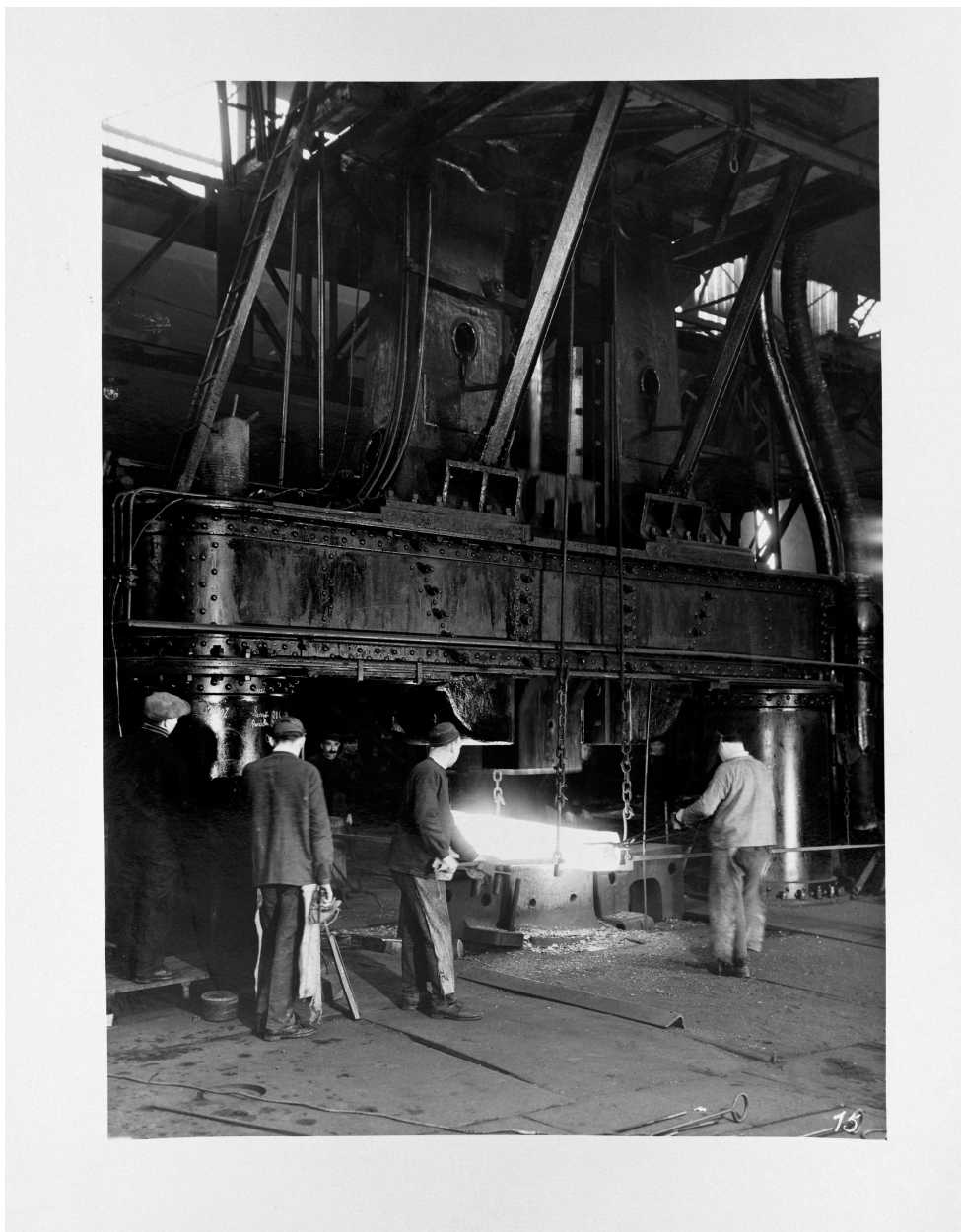
Atelier d'essieux (?) : vue générale d'un marteau-pilon. Photographie ancienne, auteur inconnu, sans date (coll. part.).
