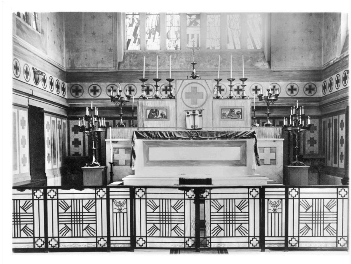
Fargniers. Église paroissiale. Vue du sanctuaire. La clôture de chœur et le maître-autel. Photographie, vers 1930 (Archives diocésaines de Soissons).
