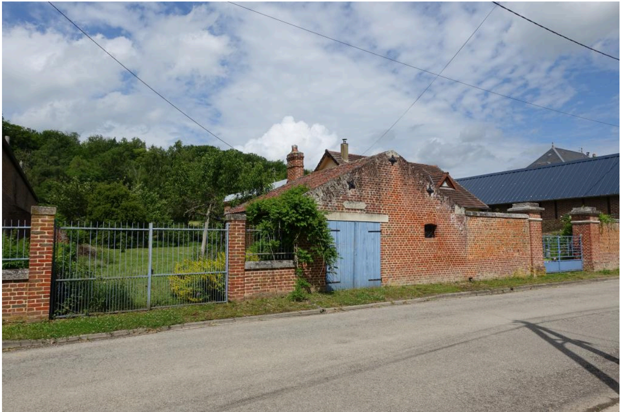
Le bâtiment de remise des pompes à incendie, vue depuis l'est.
