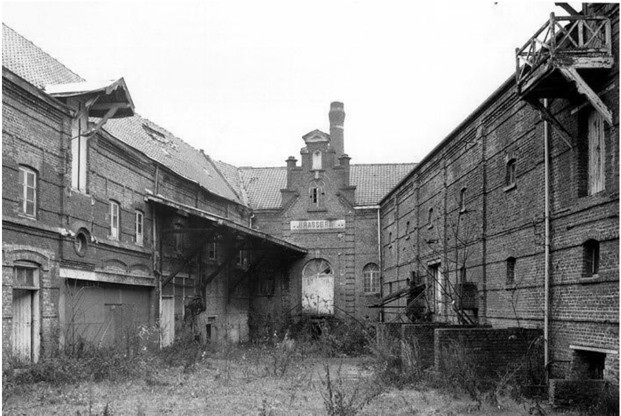
Vue générale de la cour vers le sud-est. A fond se situe la brasserie, à droite le germoir de la malterie et à gauche les écuries et le magasin à grains.
