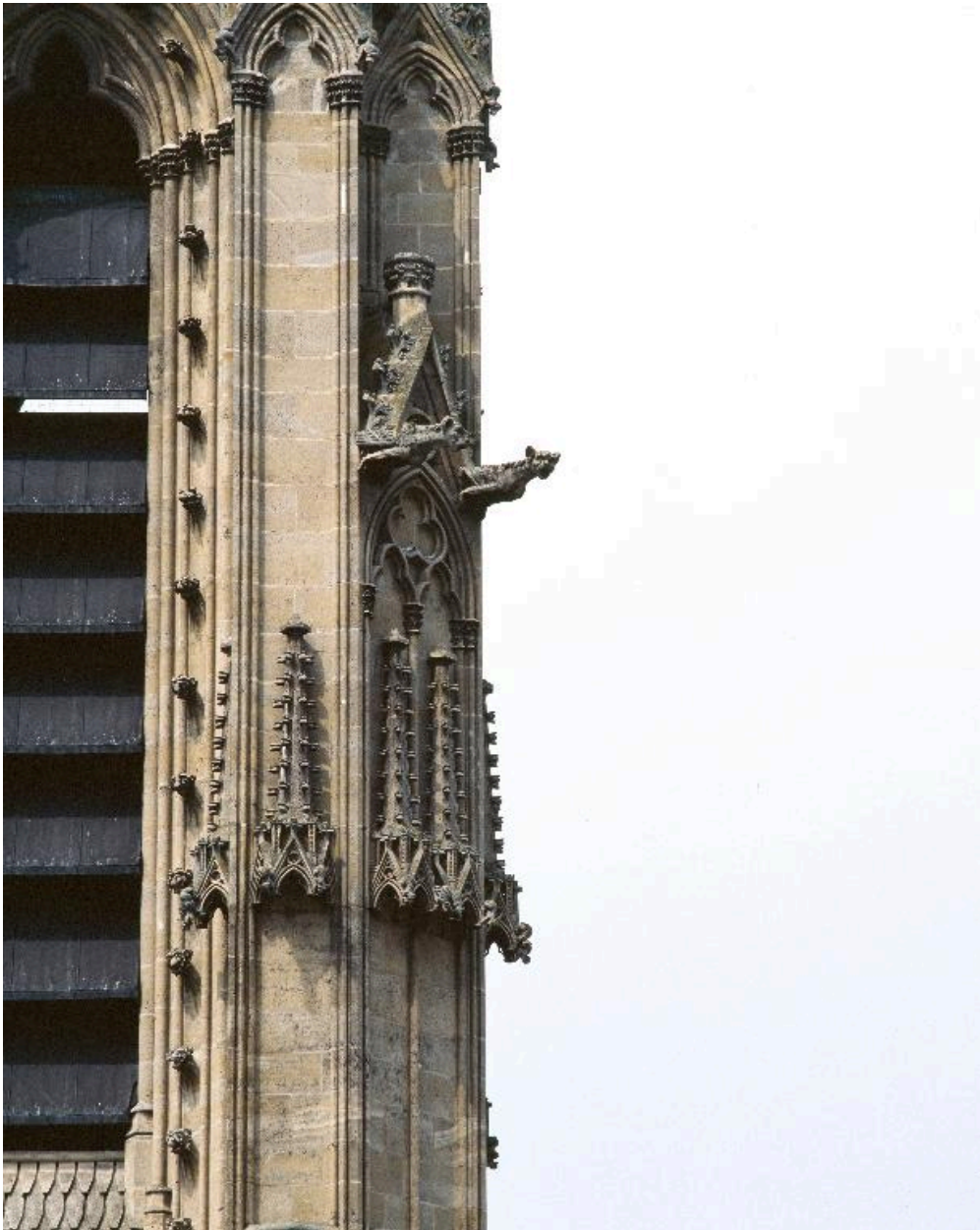
Détail de l'ornementation d'un angle du clocher.
