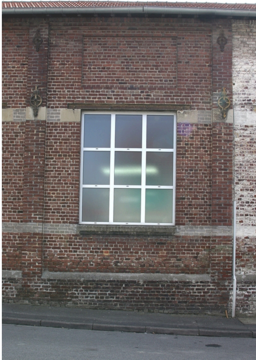
Une travée de la façade des ateliers, rue des Islots.
