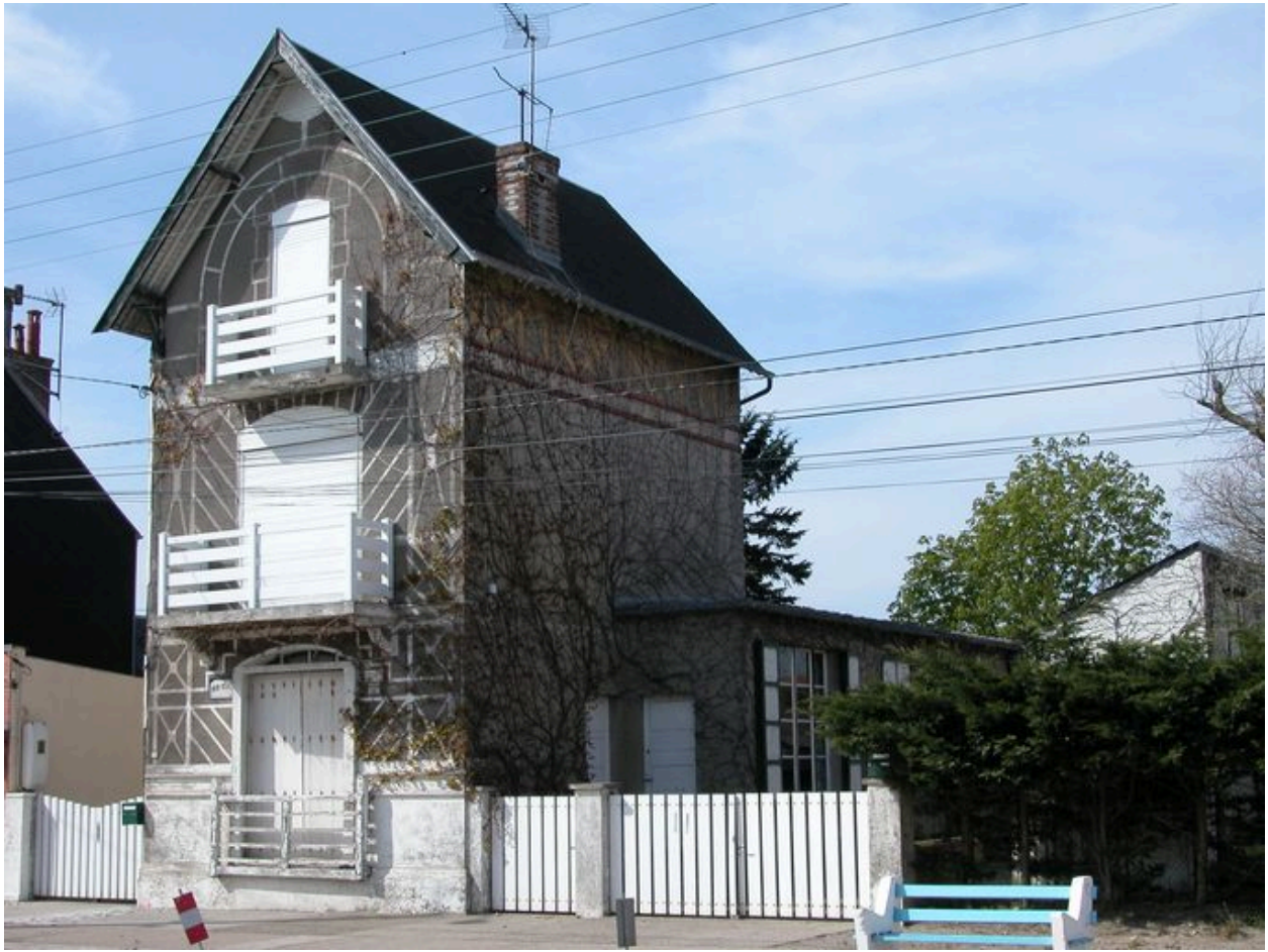
Vue de trois-quarts avec l'addition latérale.
