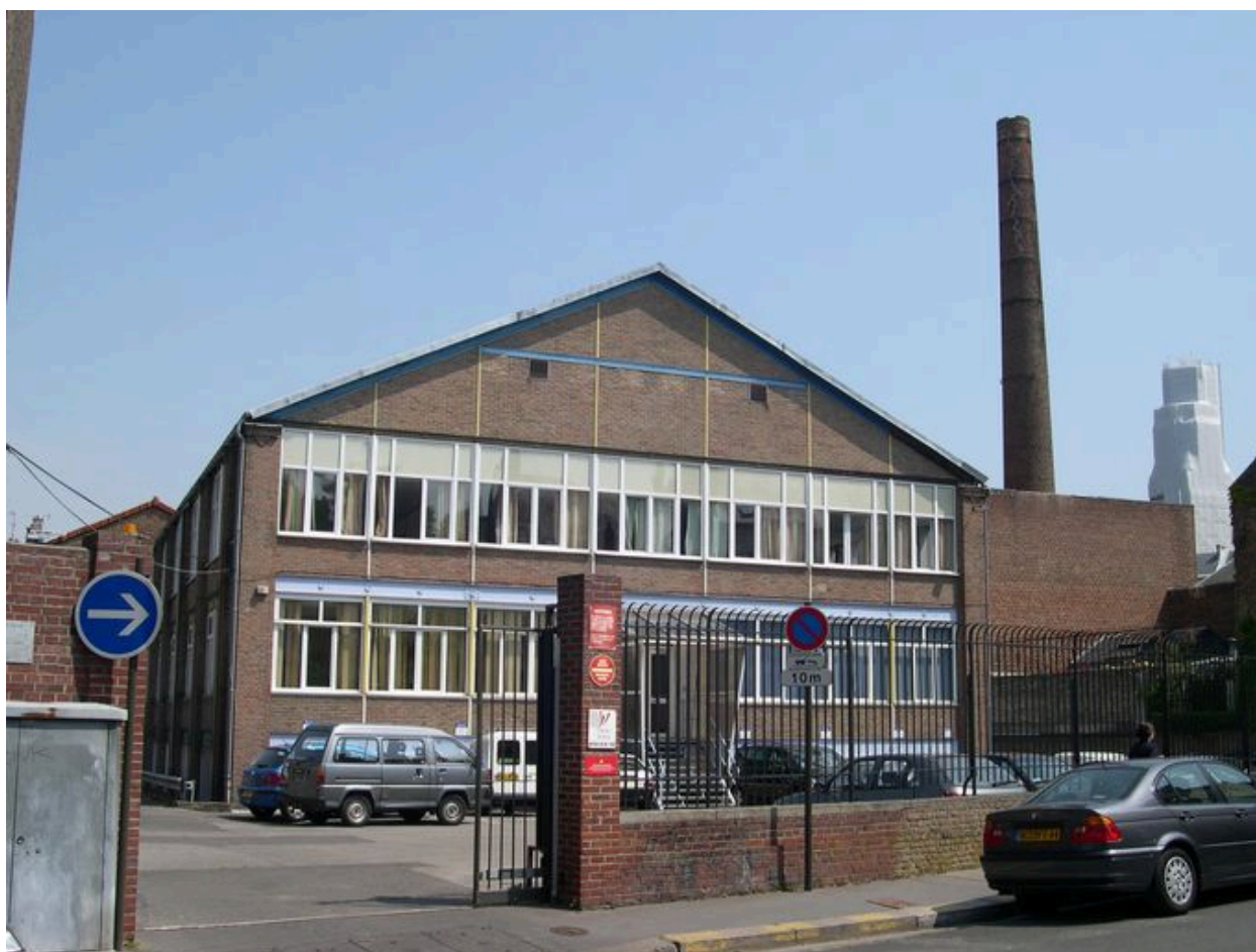
Vue depuis la rue Pierre-Lhermite, au sud.
