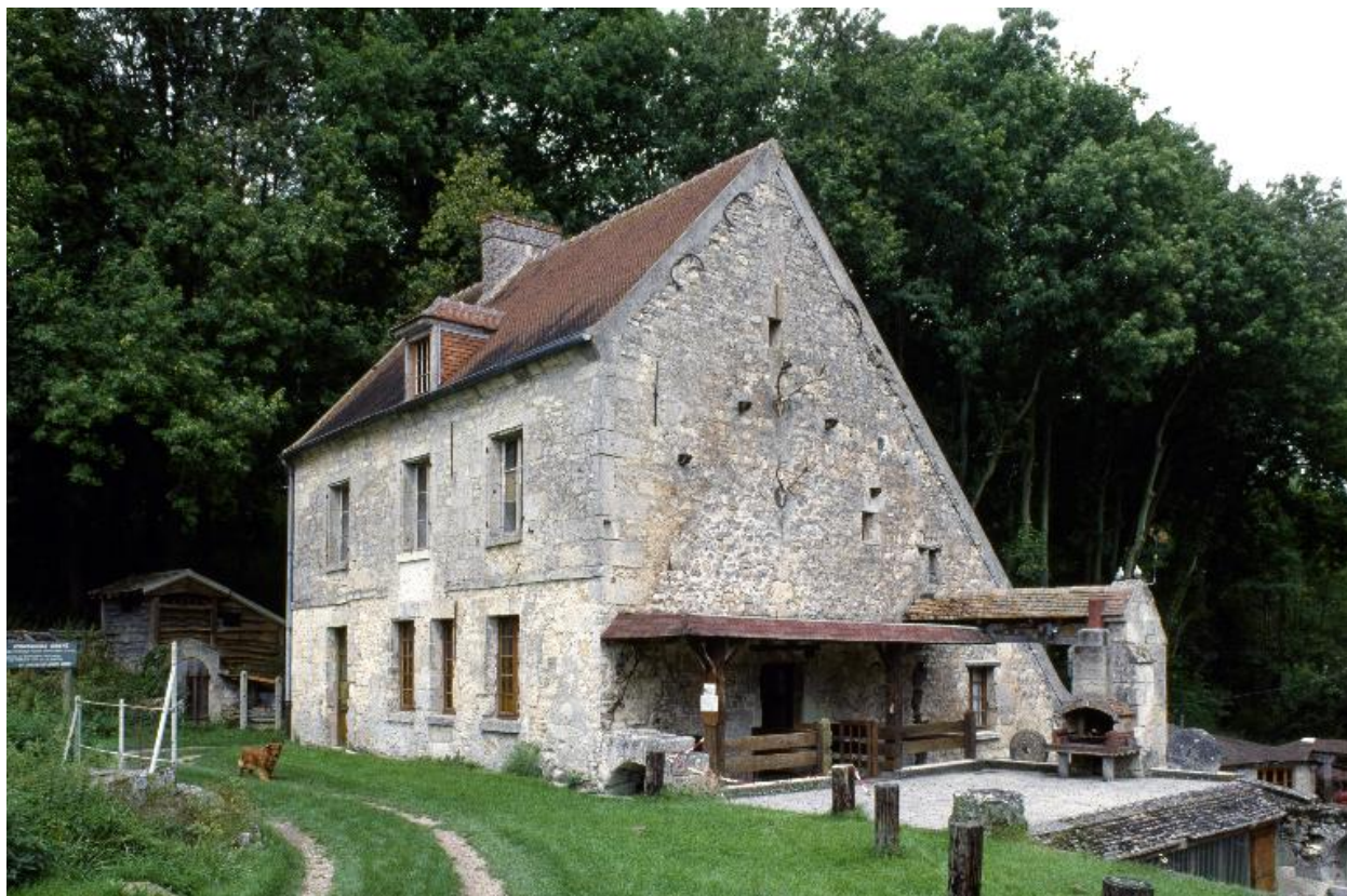
Vue du moulin depuis le sud-ouest.
