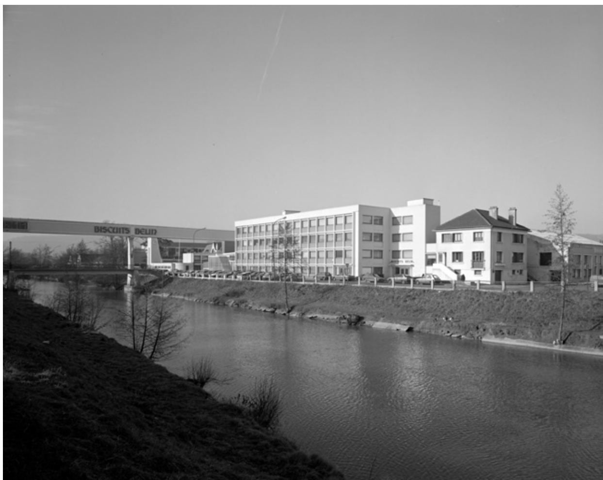
Vue de l'usine du côté de la Fausse Marne.
