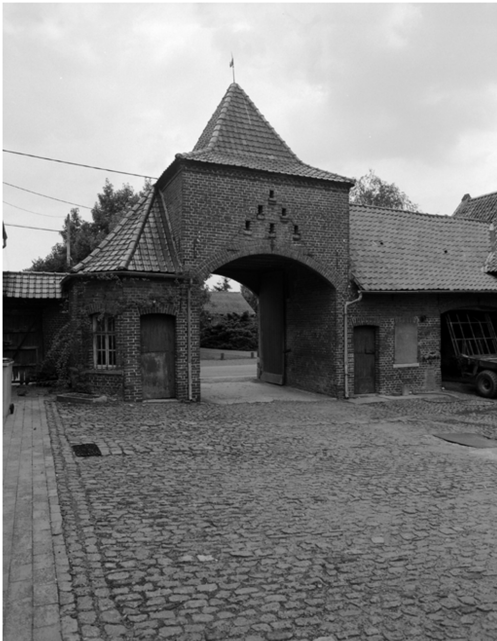
Le pigeonnier depuis la cour, 1036 rue de la Quièze.
