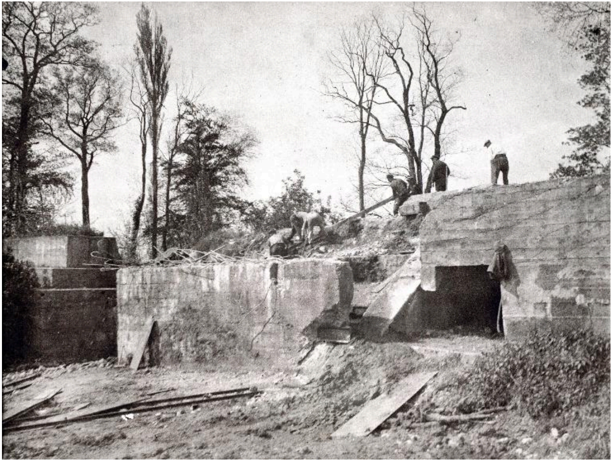
Déblaiement des installations connexes au canon
