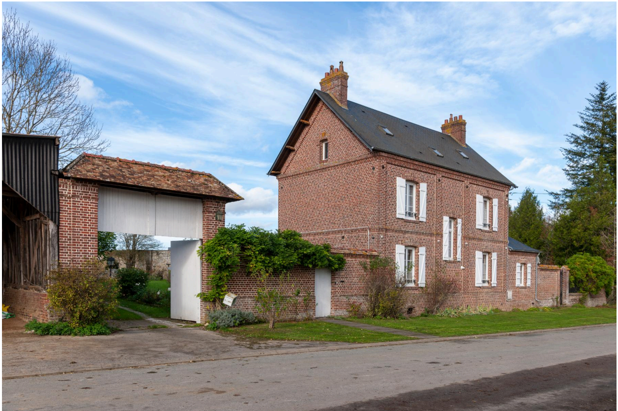
Maison, n°324 rue de Beauvais, vue depuis l'est.
