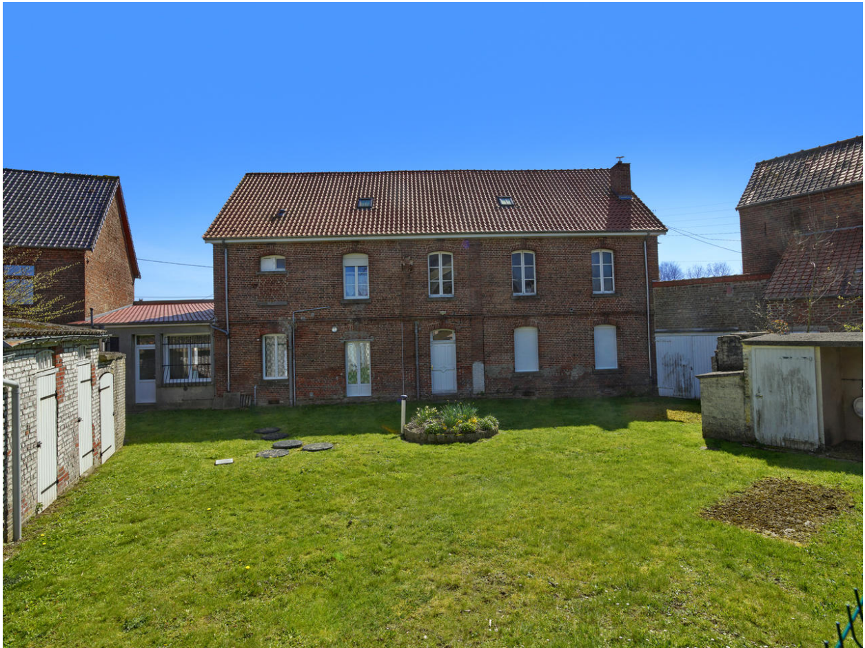
Vue de l'élévation postérieure au nord.
