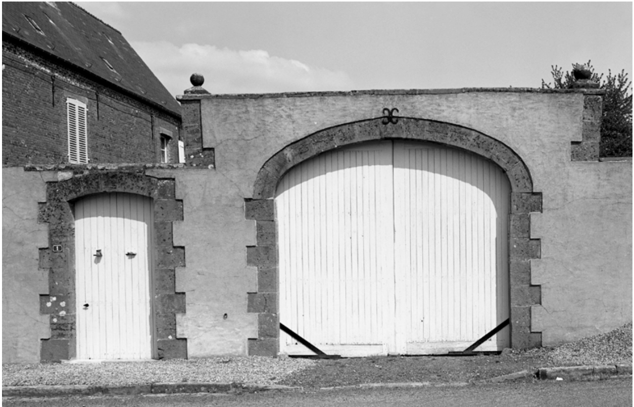
Porte charretière et porte piétonne donnant accès à la cour de ferme.
