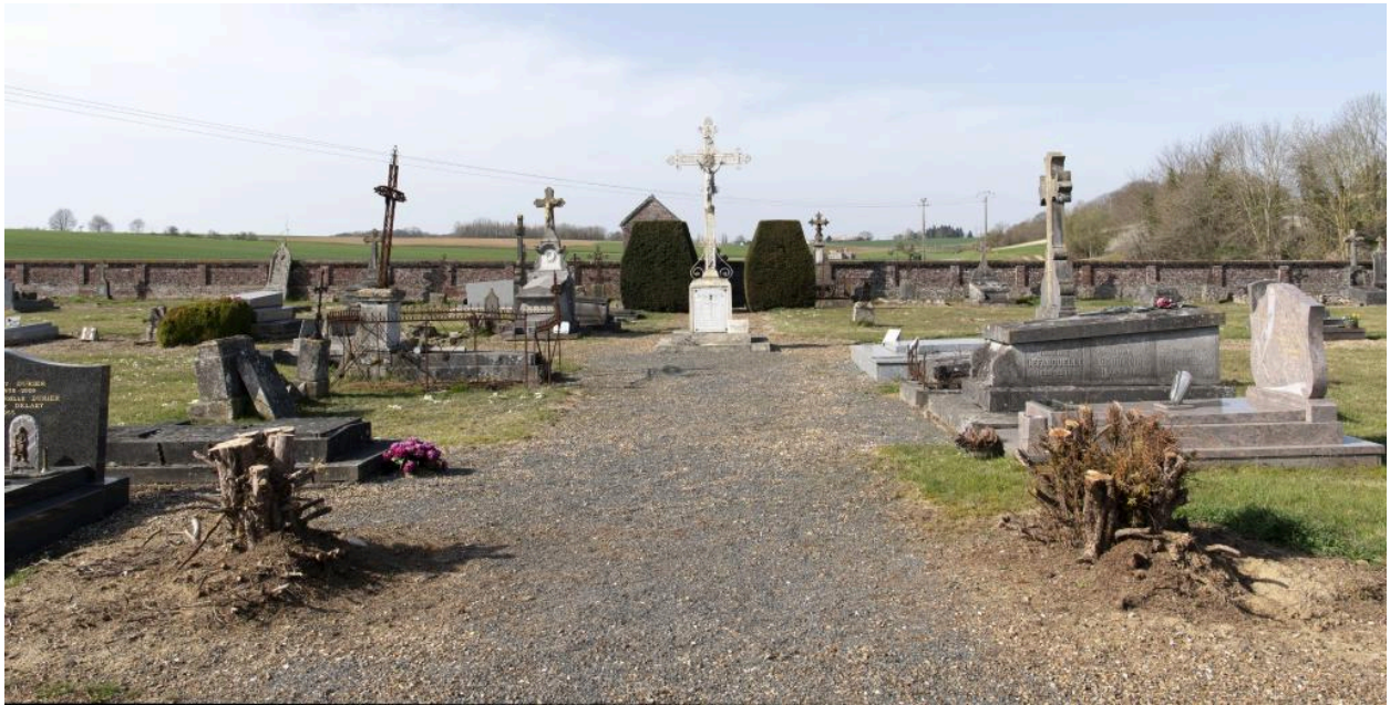
Vue générale depuis l'entrée.
