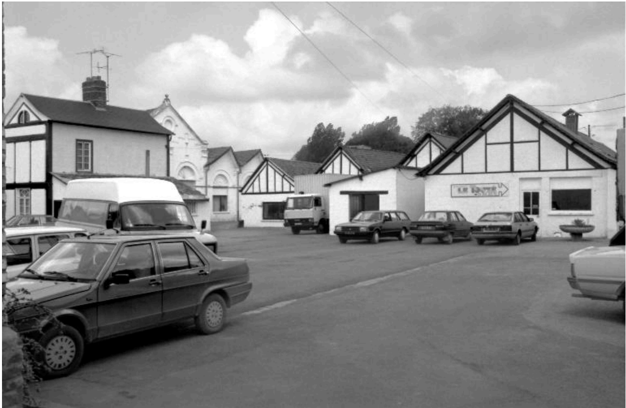
Ateliers de fabrication et bureaux.
