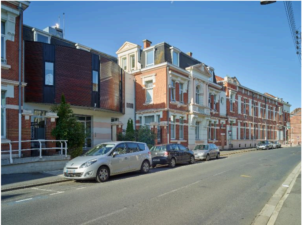
Vue partielle de la façade de l'hôpital depuis la rue Louise de Bettignies.
