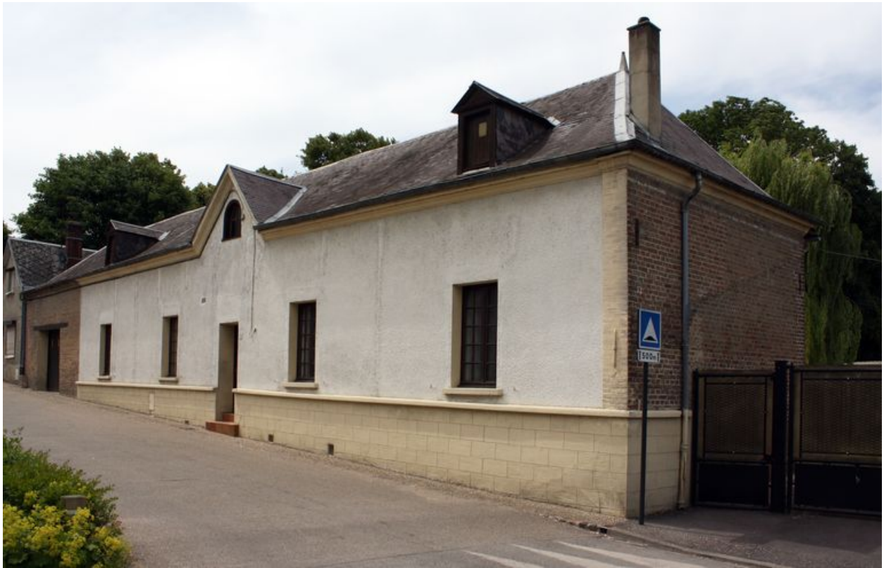
Ferme, rue du 8-mai-1945, reconstruite au milieu du 19e siècle.
