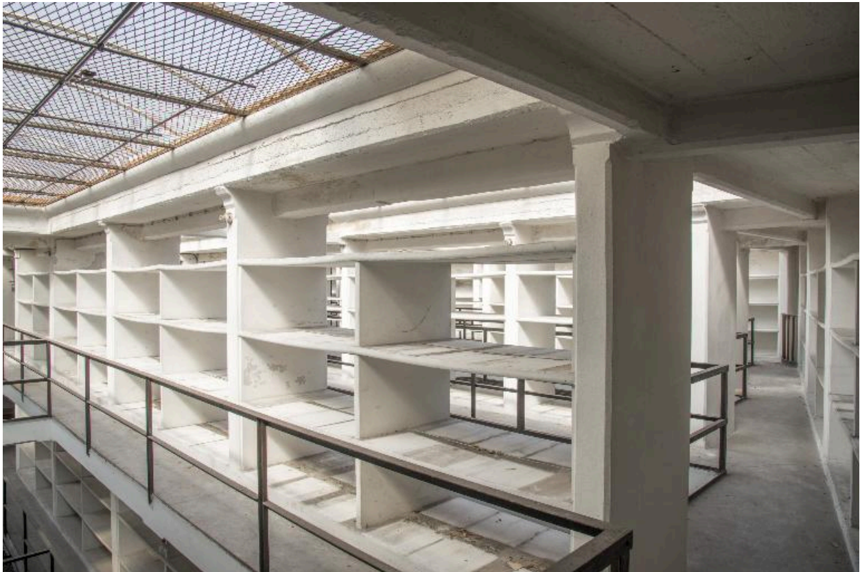
Bâtiment du dépôt, troisième étage : vue de l'extrémité est du dépôt depuis le vaisseau 4.
