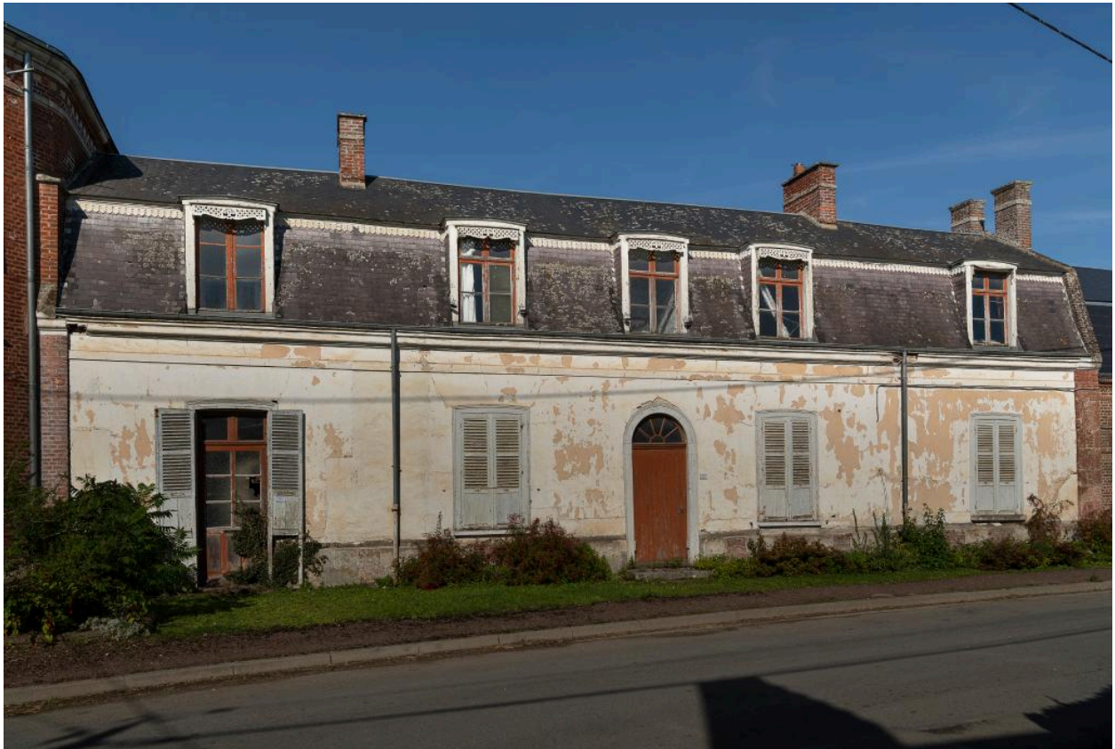
Vue générale depuis la rue Saint-Cyr de la façade sud de l'ancien logis de la ferme dite du chapitre.
