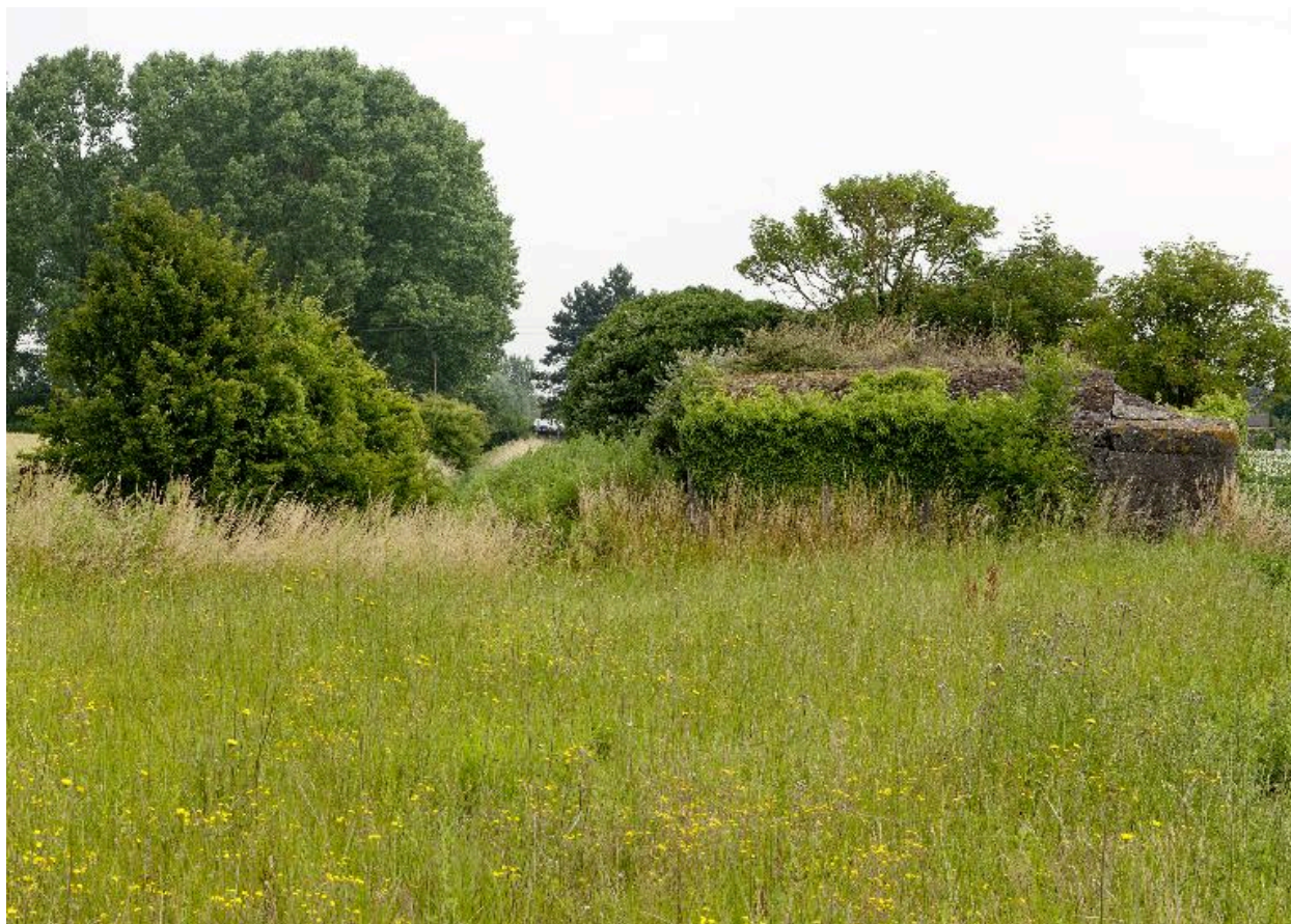
Bâtiment A, vue latérale, vers le nord
