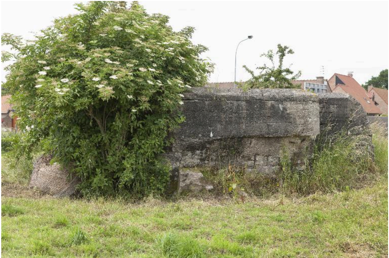
Casemate a, vers le sud-ouest
