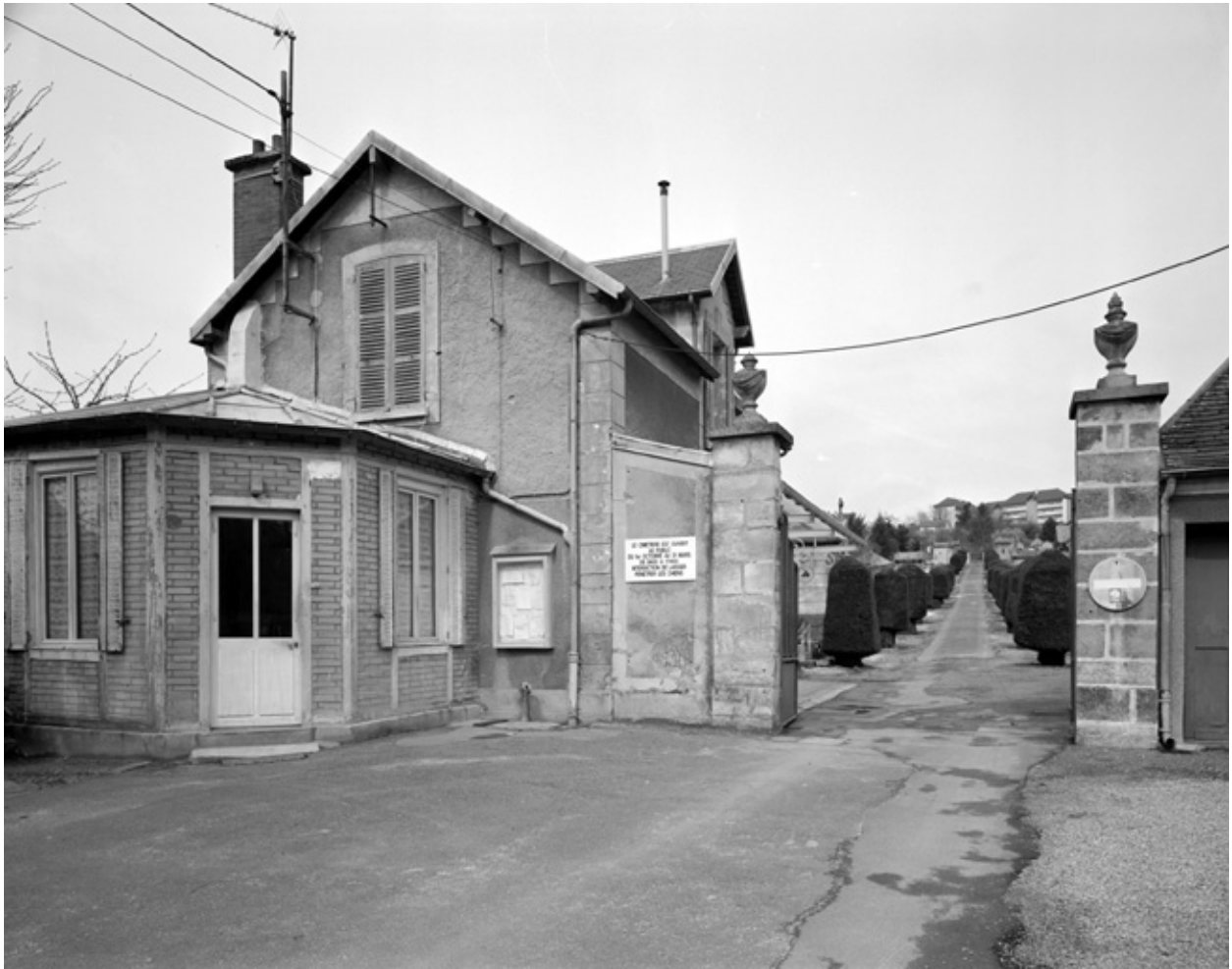
Portail et pavillon d'entrée.
