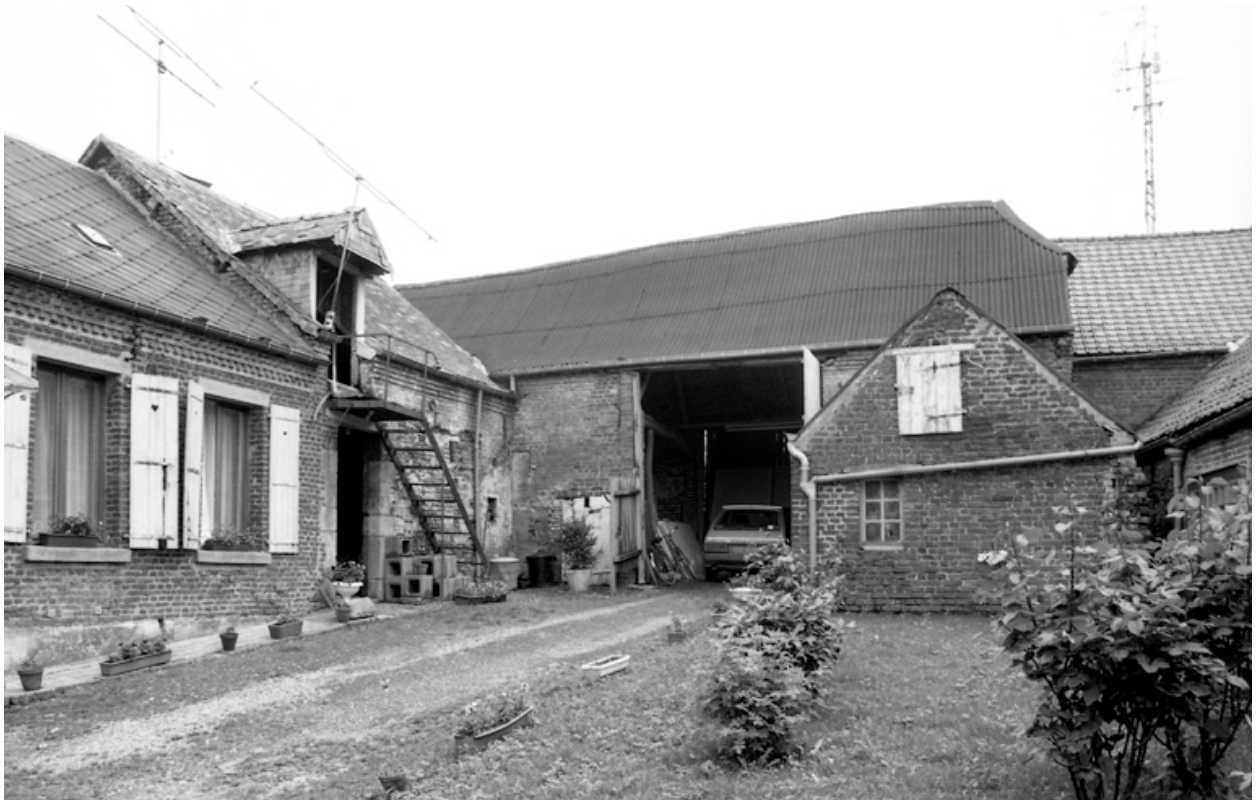
Vue d'ensemble des bâtiments agricoles, depuis le nord-ouest.
