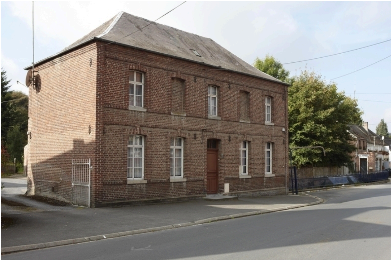
Vue du second logis, depuis la voie.
