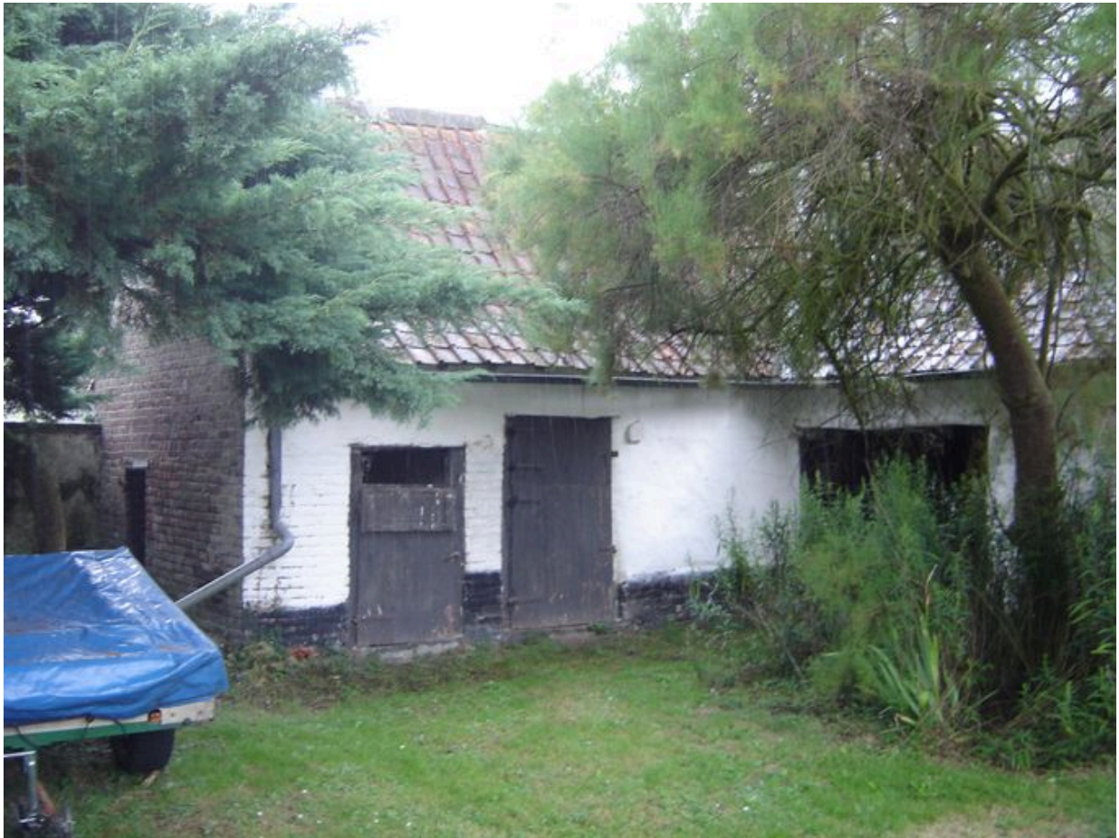
Vue de l'écurie en fond de cour.
