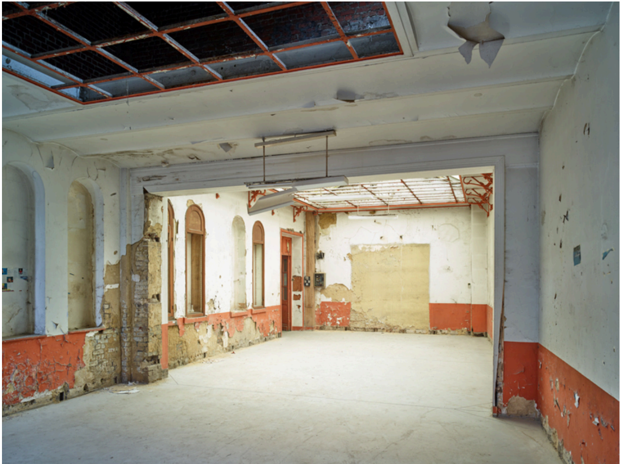
Bâtiment technique, rez-de-chaussée. Vue vers l'ouest.
