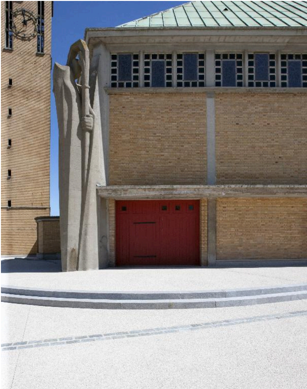
Entrée flanc sud de l'église.
