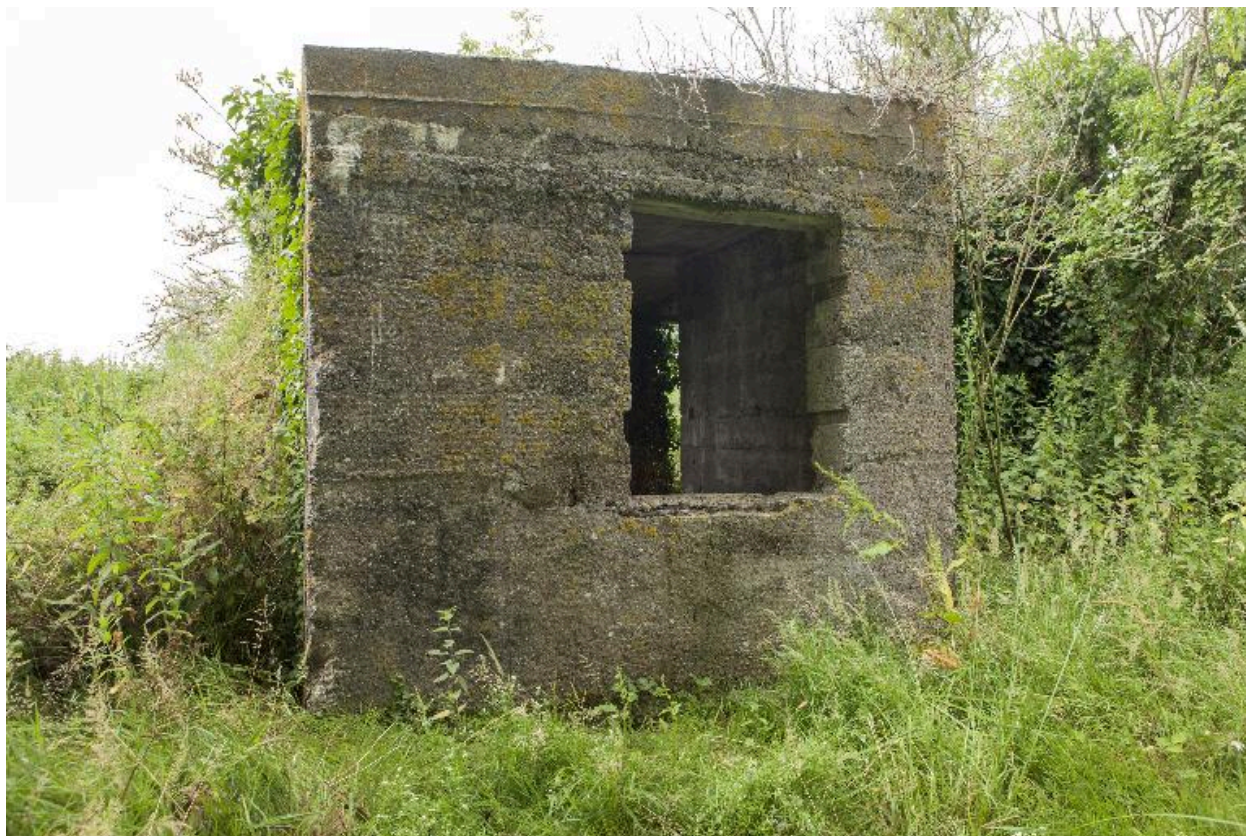
Casemate a), élévation ouest
