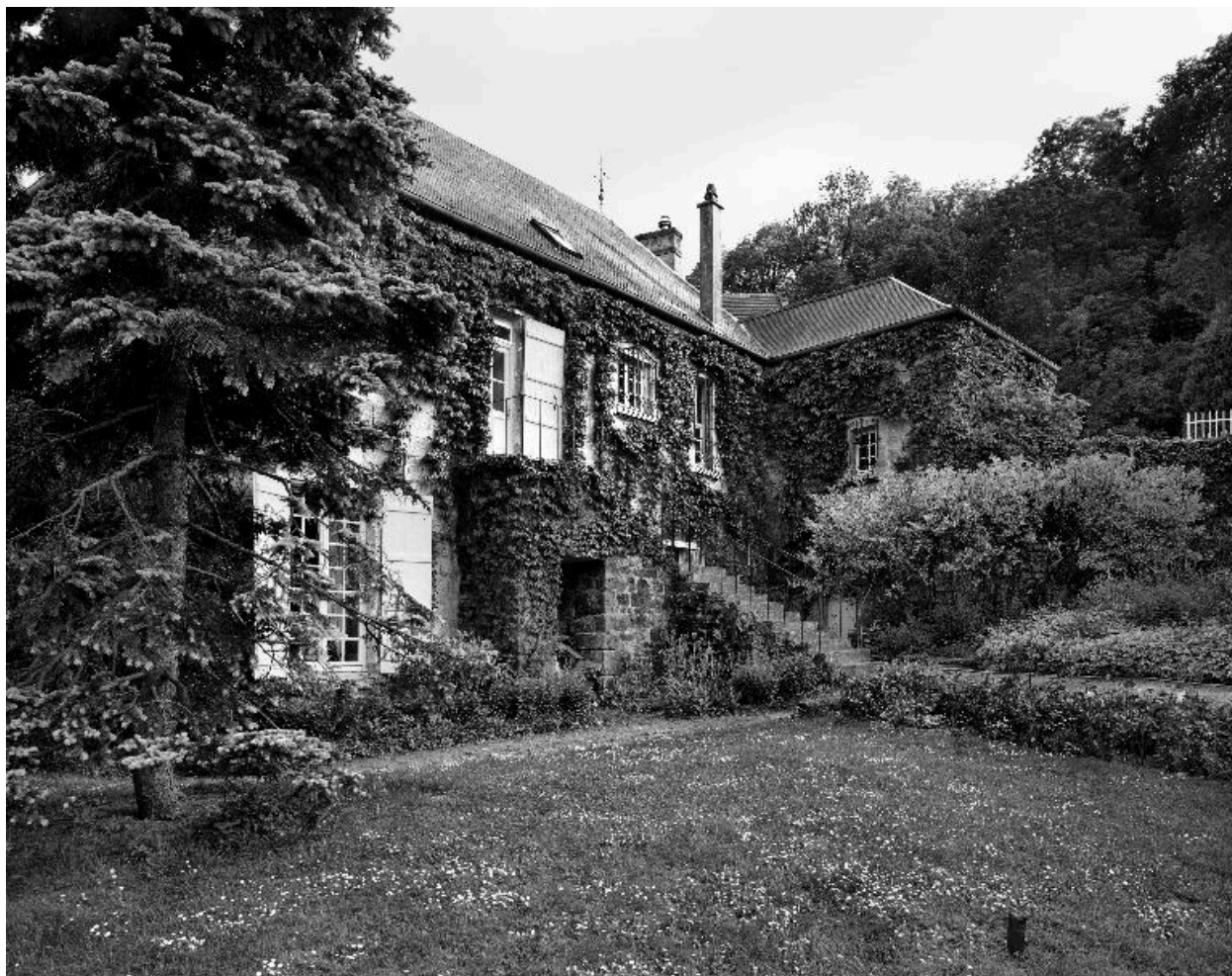
Vue générale nord.
