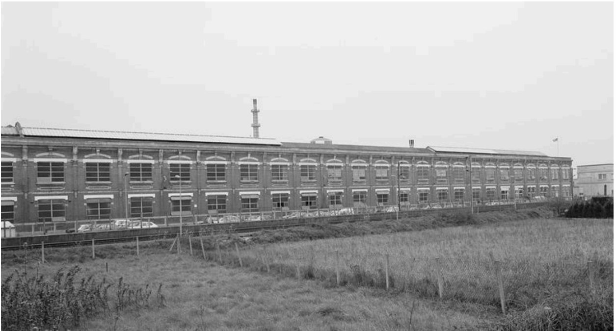
Atelier de fabrication ouest, vue partielle.
