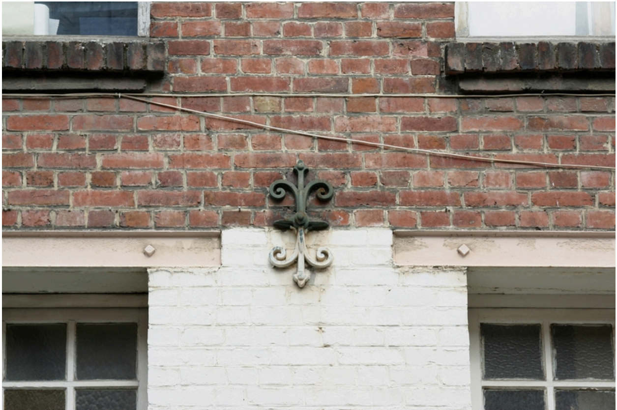
Façade antérieure des ateliers : détail.
