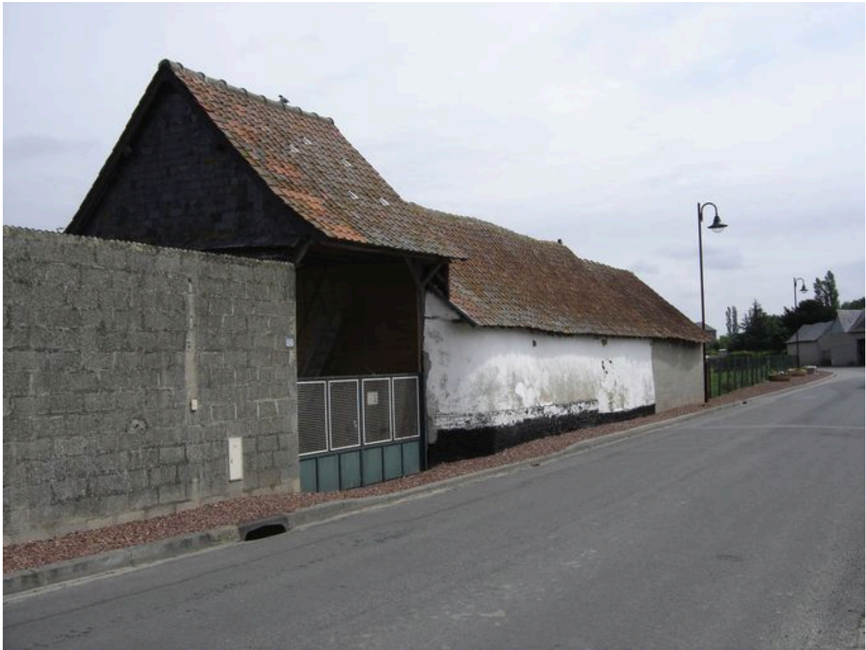
Vue de l'entrée depuis la rue.
