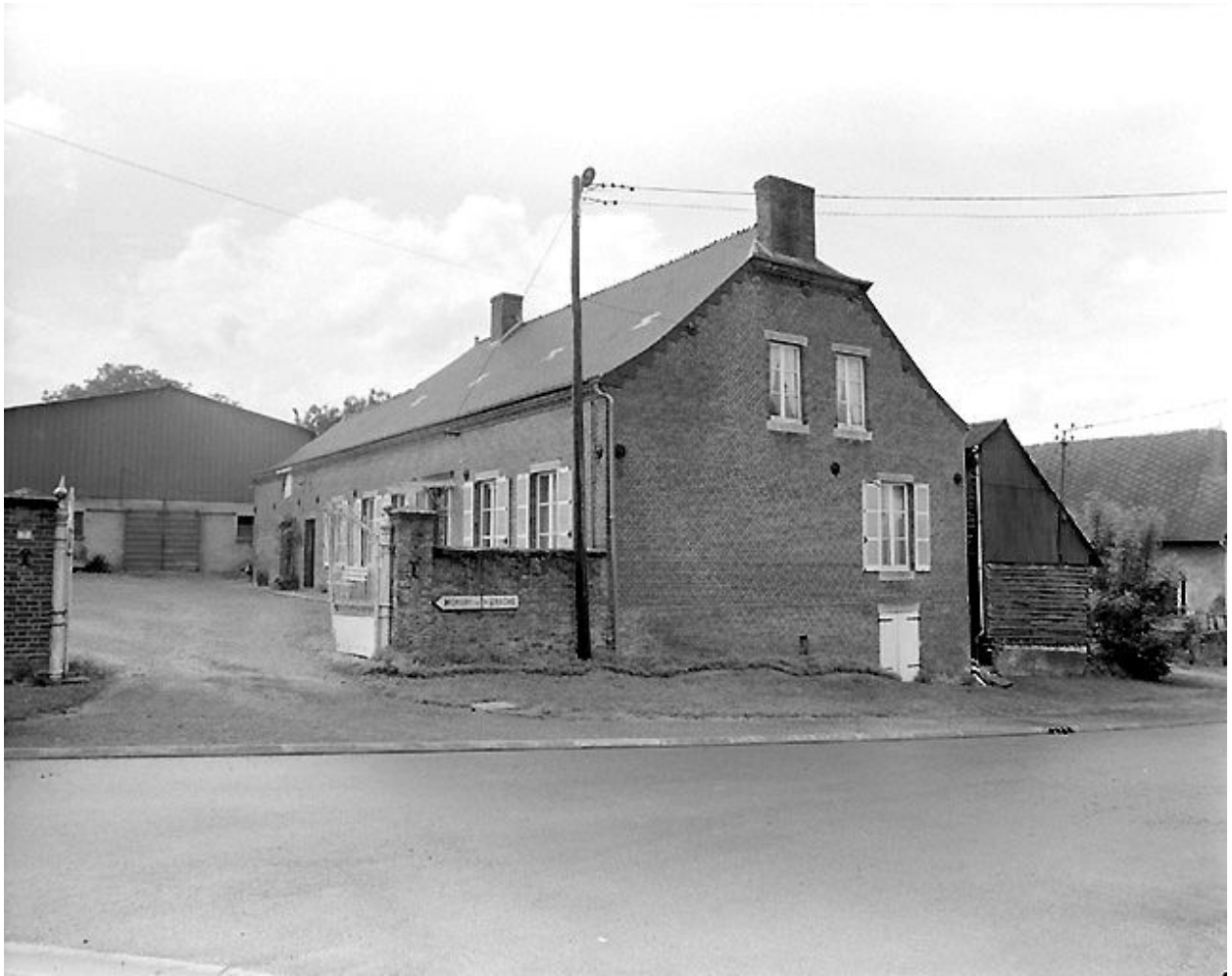
Vue du logis depuis la rue.
