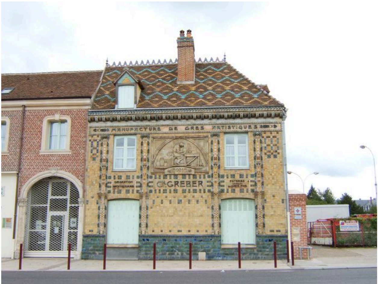
Façade sur rue de la Manufacture Gréber.
