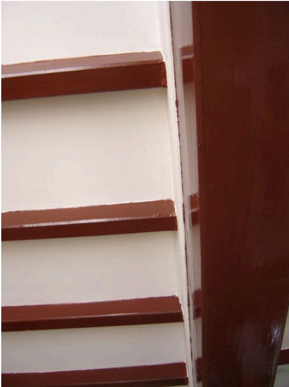
Vue des poutres et solives de la salle.
