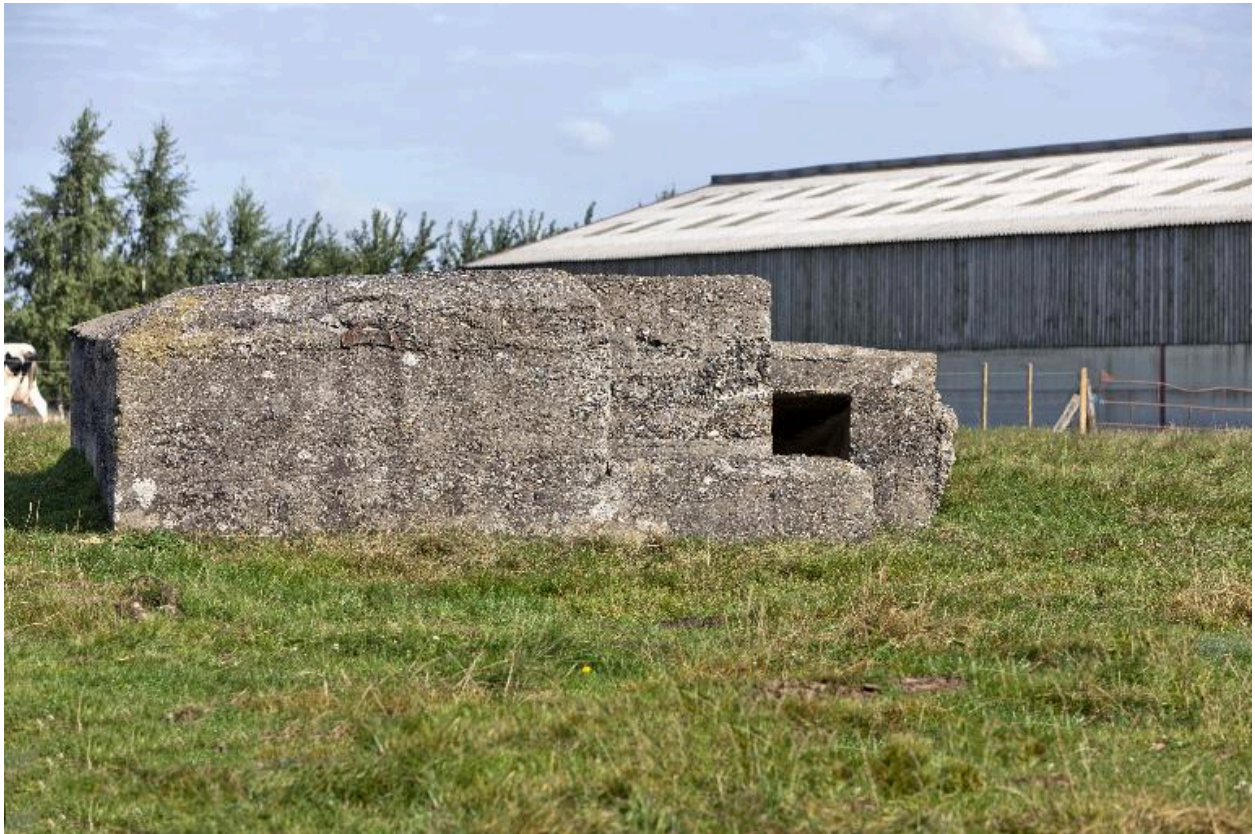
Vue longitudinale, vers le nord
