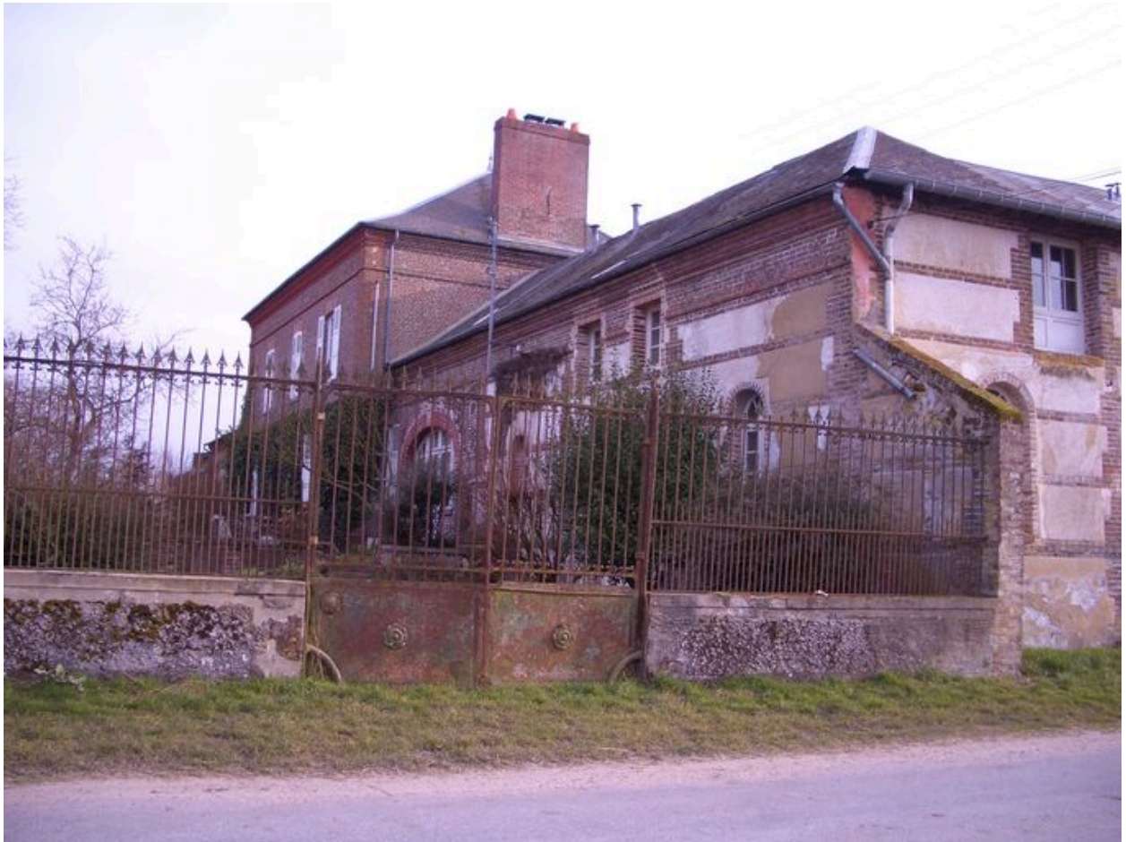
Vue postérieure du logis depuis la rue.
